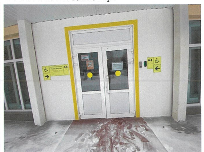
ФОТО № 18 Входная дверь
