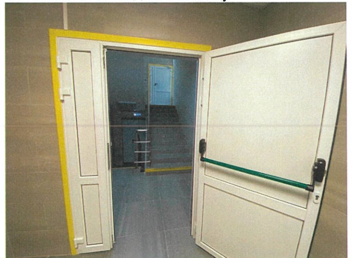
ФОТО № 30 Выход на лестницу
