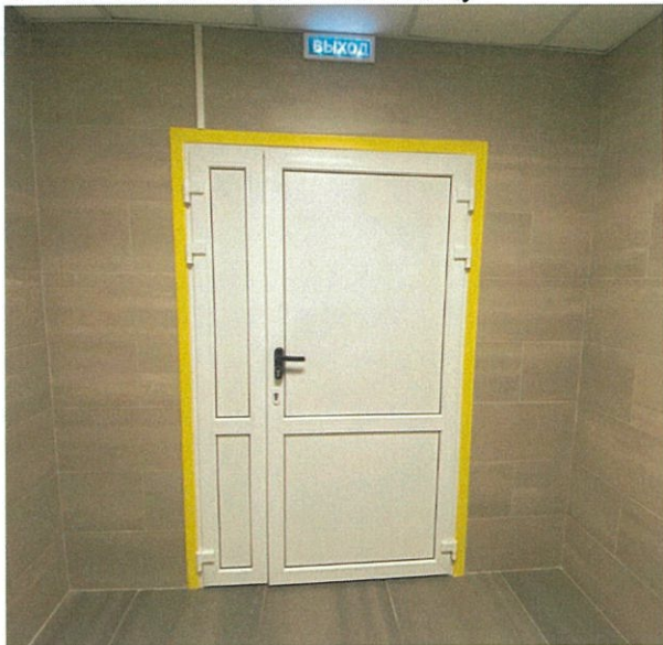
ФОТО № 31 Выход на лестницу
