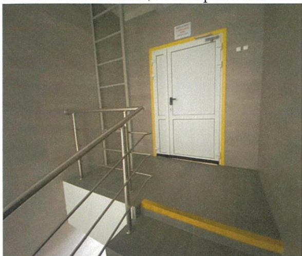
ФОТО № 37 Лестница на второй этаж
