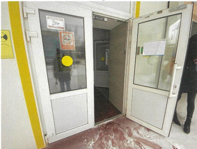
ФОТО № 19 Входная дверь
