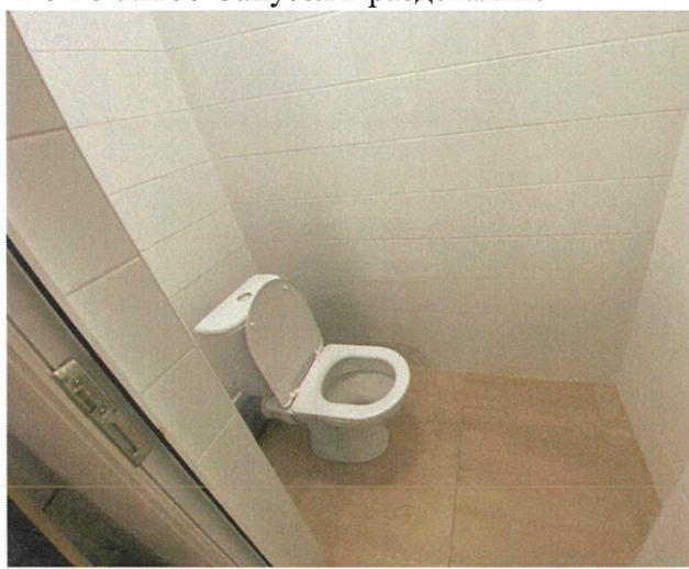
ФОТО №106 Санузел в раздевальне
