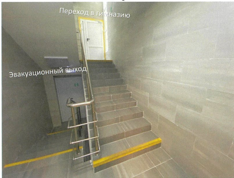
ФОТО № 32 Лестница на второй этаж
