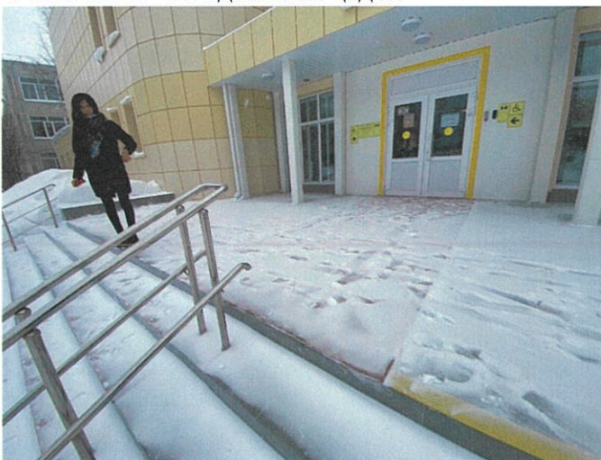
ФОТО № 17 Входная площадка
