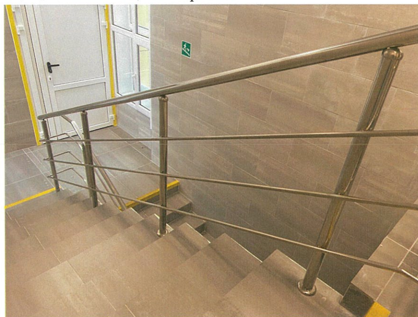
ФОТО № 35 Лестница на второй этаж
